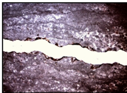
Рис. 19а. Темно-коричневый битум на стенках открытой трещины
